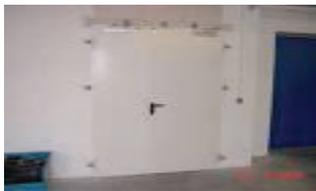
**Feuerschutztüren und Feuerschutztore** müssen selbsttätig schließen. Türen mit Brandfallsteuerung werden in ihrer Funktion geprüft und es müssen Nachweise über jährlich durchgeführte Prüfungen durch eine Fachfirma vorliegen.
