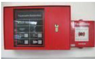
**Brandmeldeanlagen, Rauch- und Wärmeabzugesanlagen** und stationäre Löschanlagen sind jährlich von befugten Fachfirmen zu warten. Eine positive Abnahmeprüfung durch eine befugte Fachperson muss vorliegen.
